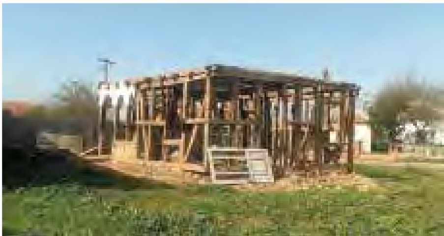
Дрвена конструкција (недостаје кров) „чатмаре“ из XIX и прве половине XX века
